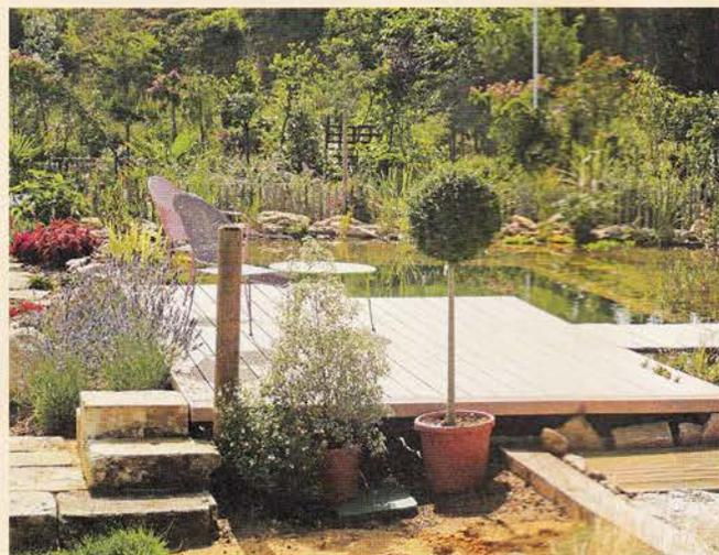
▲ **WPC-Terrasse** Die massiven Verbundholzdielen von Silvadec bestehen zu 60 % aus Holzfasern (PEFC-zertifizierte Fichte und Douglasie), zu 30 % aus Hightech-Polymeren und zu 10 % aus Pigmenten. [www.silvadec.com](http://www.silvadec.com), [www-kurz-kg.de](http://www-kurz-kg.de)
